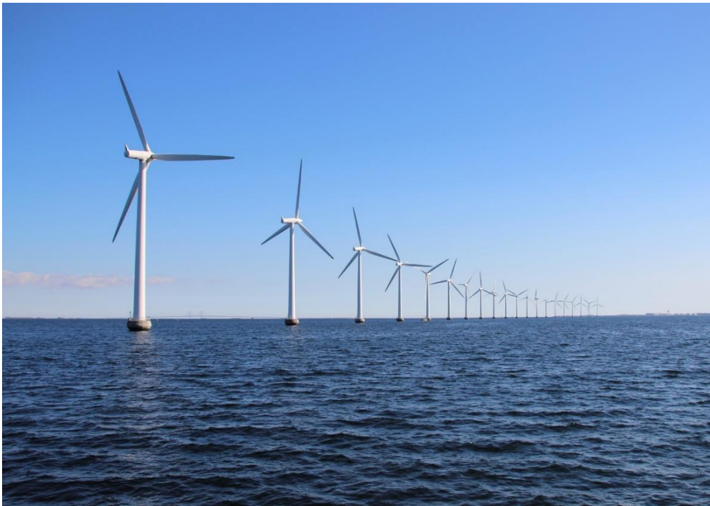
Na sliki: Polje vetrnih elektrarn na morju
